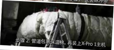
步骤2: 管道包裹保温棉, 再装上X-Pro 1主机
