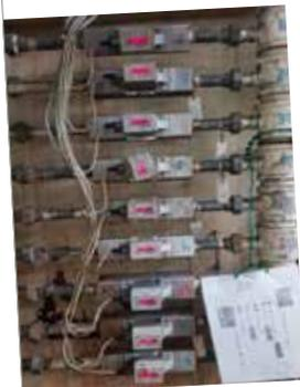
厂内有9个带水表的二级小管，水表用来观察并且确保稳定的流速。如果水管堵塞导致流速下降，则会引起高周波热处理机不能正常运作。因此，在安装沃肯(Vulcan)前，必须每2-3个月清洁一次管道。
